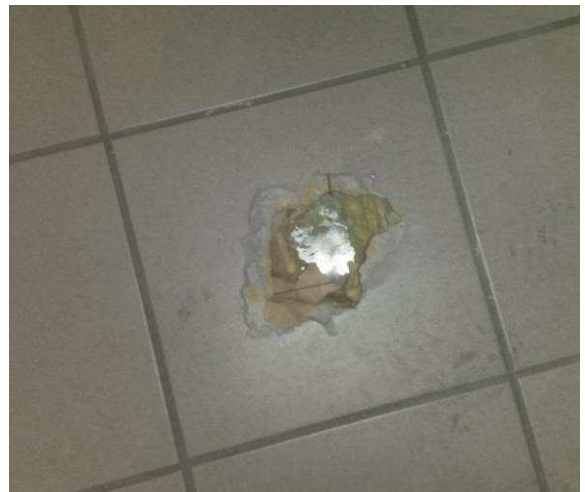
Trou de sondage S47-6 – Présence d'une plaque métallique.
