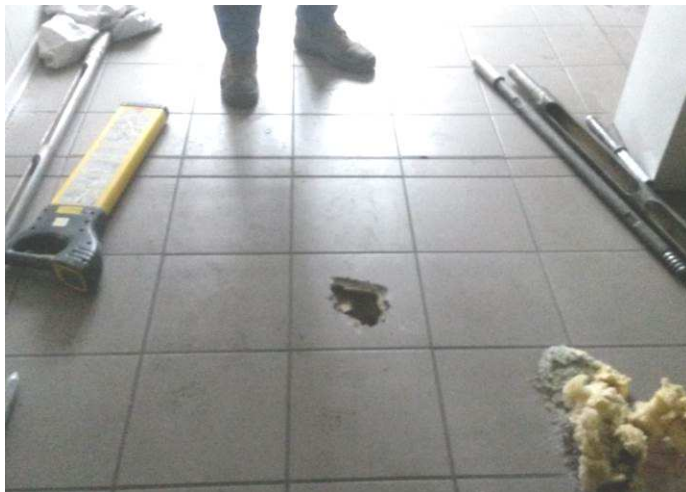
Trou de sondage S47-6 – Présence d'une plaque métallique.
